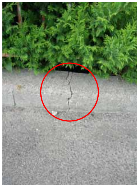
写真 6-12 No.95 マンホール周辺道路の被災状況
