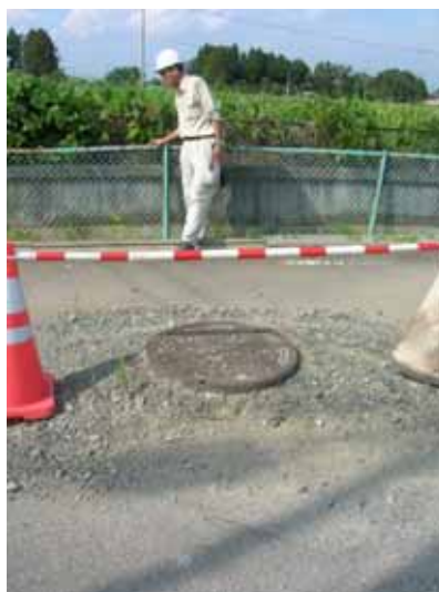
写真 6-4 測定箇所（未対策 No.711 マンホール）
