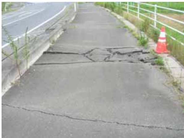
写真 6-54 No.55 周辺の路面状況 1
