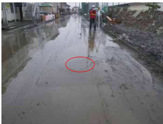
写真 6-71 測定箇所（対策済み No.19-1 マンホール）
