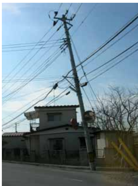
写真 6-87 電柱の傾き
