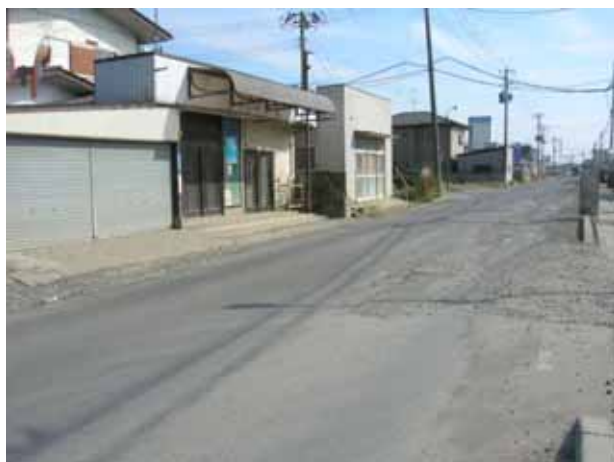
写真 6-82 No.33-1 付近の路面状態
