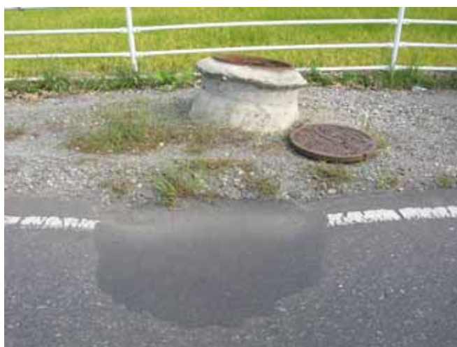
写真 6-6 測定箇所（未対策 No.713 マンホール）
