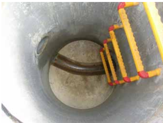
写真 6-81 No.32-1-2 マンホールの内部写真
