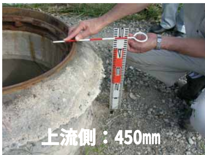
写真 6-9 マンホールの上流側および下流側の隆起高さ
