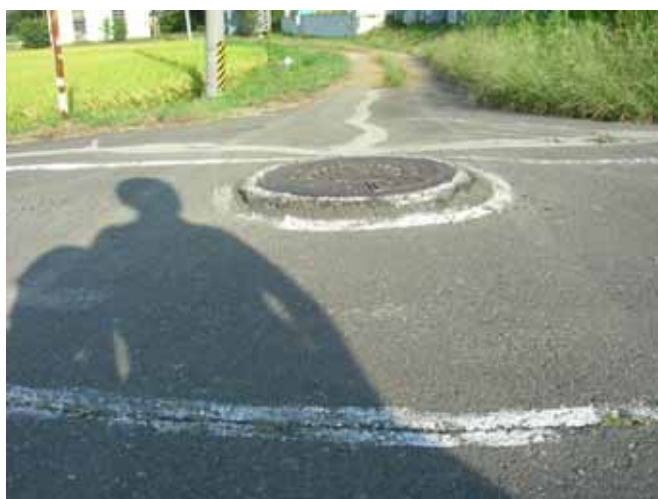
写真 6-25 測定箇所（未対策 No.1089-1 マンホール）
