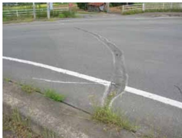
写真 6-57 No.55 周辺の路面状況 4
