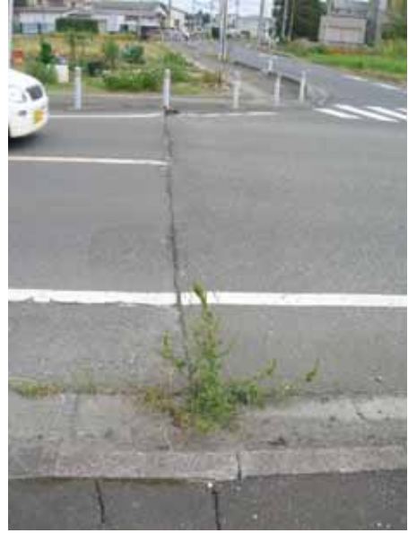
写真 6-60 No.57 周辺の路面状況 2
