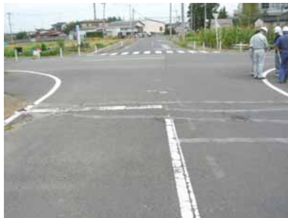
写真 6-61 No.57 周辺の路面状況 3
