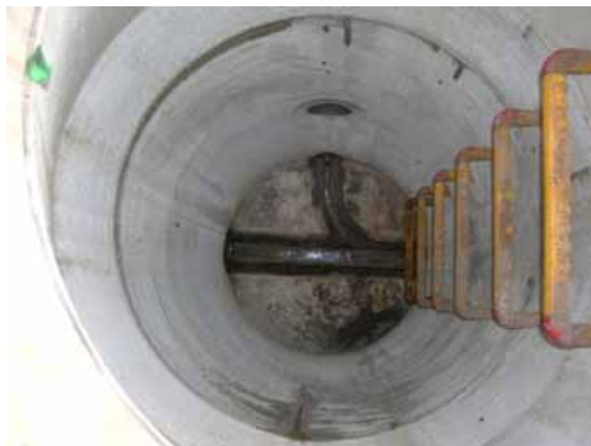
写真 6-32 No.1089-1 マンホールの内部写真
