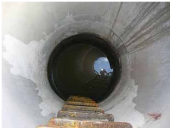
写真 6-11 No.713 マンホールの内部写真
