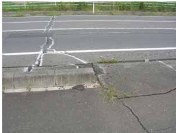
写真 6-55 No.55 周辺の路面状況 2
