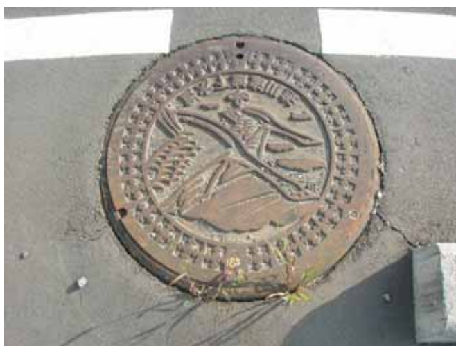
写真 6-22 測定箇所（対策済み No.185-3 マンホール）
