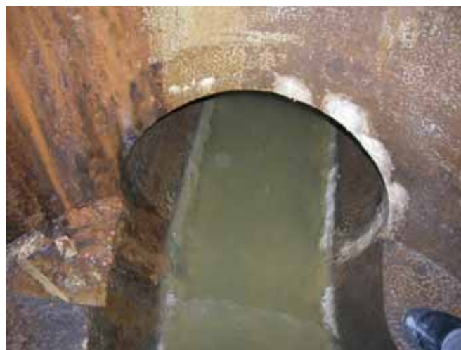
写真 6-31 管路との継ぎ手部分
