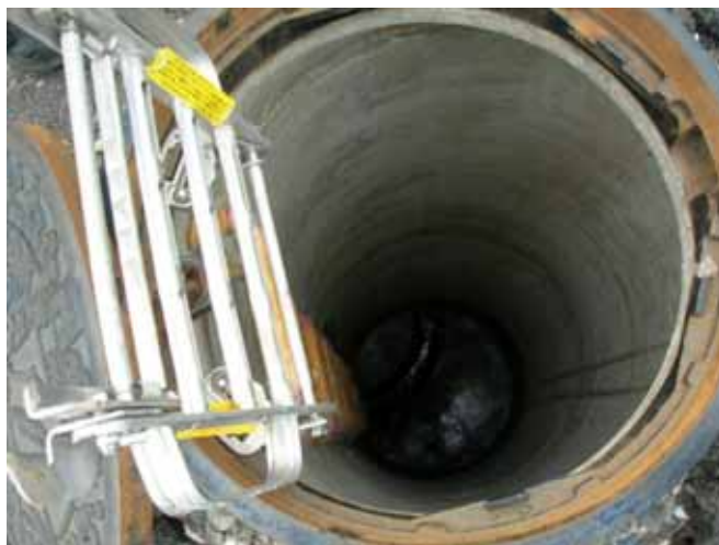
写真 6-48 No.8079 マンホールの流下状況
