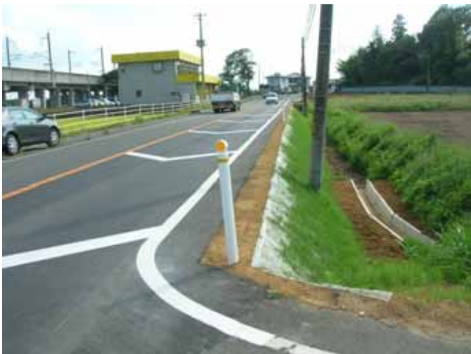
写真 6-15 道路脇の法面補修状況（上流側）
