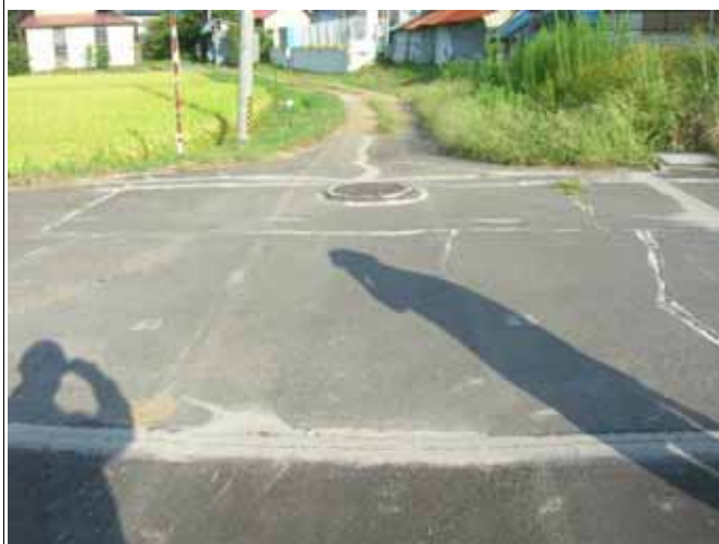
写真 6-37 No.1089-1 路面状況
