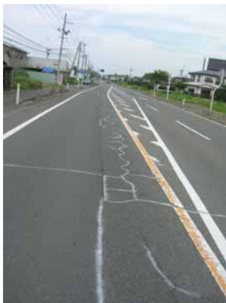
写真 6-58 No.55 周辺の路面状況 5
