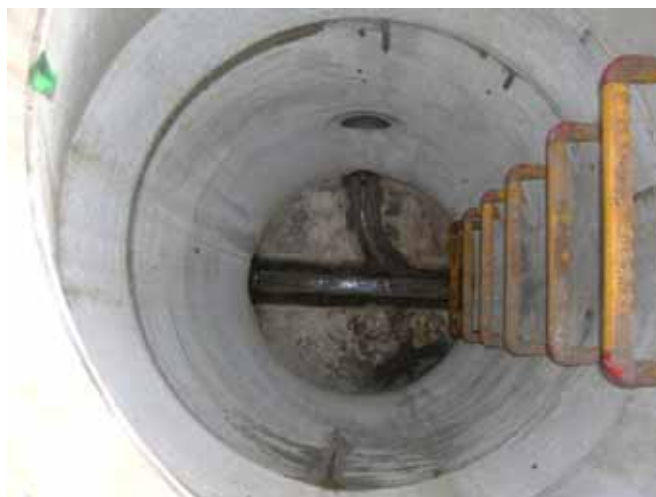
写真 6-34 No.1089-1 マンホールの流下状況
