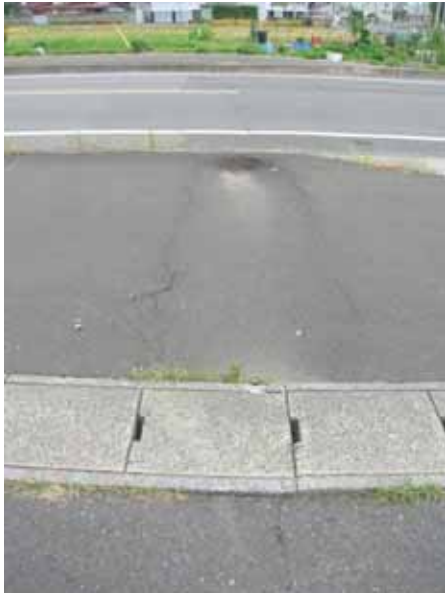
写真 6-59 No.57 周辺の路面状況 1
