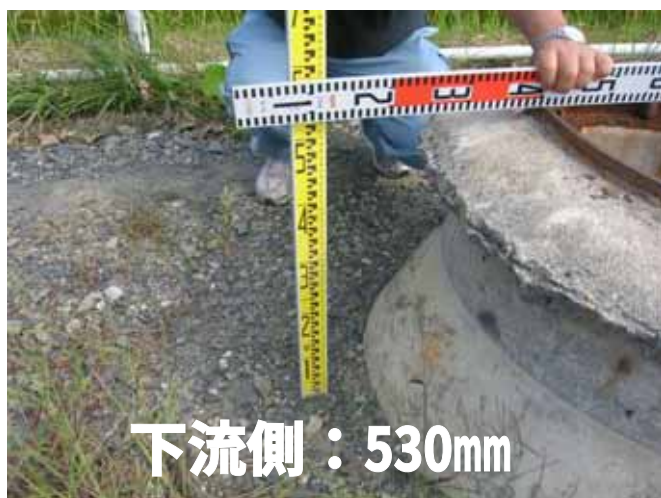
写真 6-9 マンホールの上流側および下流側の隆起高さ
