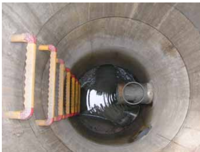
写真 6-79 No.33-1 マンホールの内部写真
