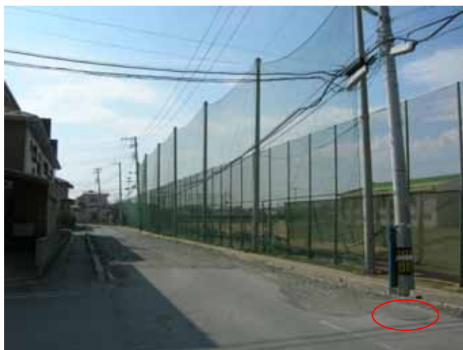
写真 6-70 測定箇所（対策済み No.17-1 マンホール）
