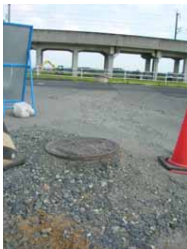
写真 6-5 測定箇所（未対策 No.712 マンホール）
