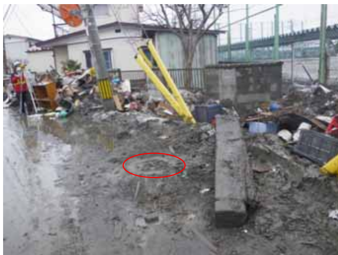
写真 6-69 測定箇所（対策済み No.51-1 マンホール）
