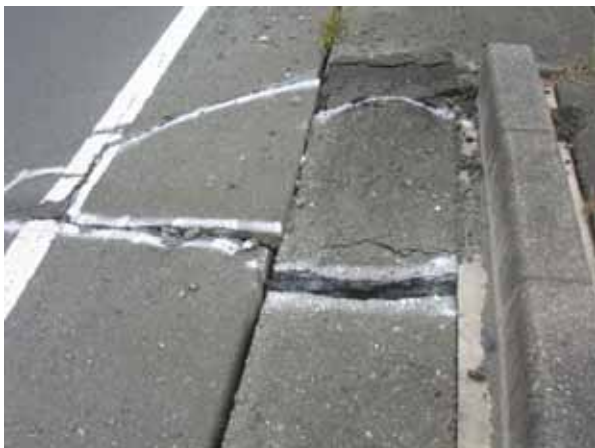
写真 6-56 No.55 周辺の路面状況 3
