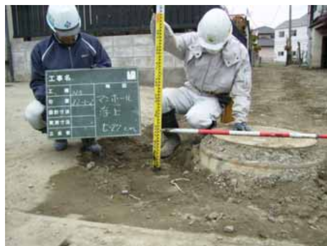
写真 6-77 測定箇所（未対策 No.32-1-2 マンホール）
