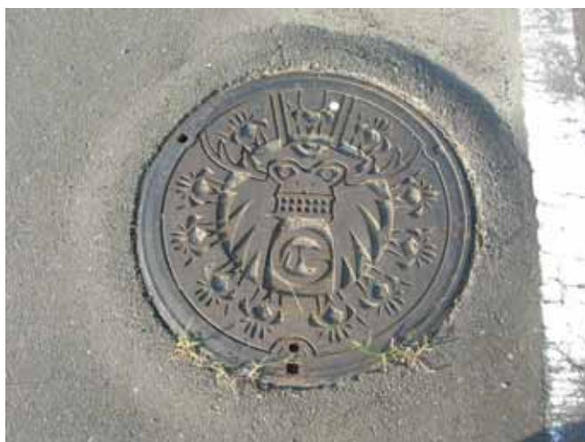
写真 6-24 測定箇所（未対策 No.1088-2 マンホール）
