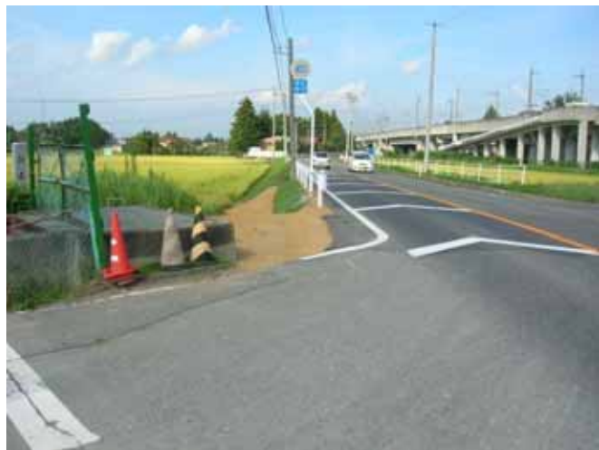
写真 6-16 道路脇の法面補修状況（下流側）
