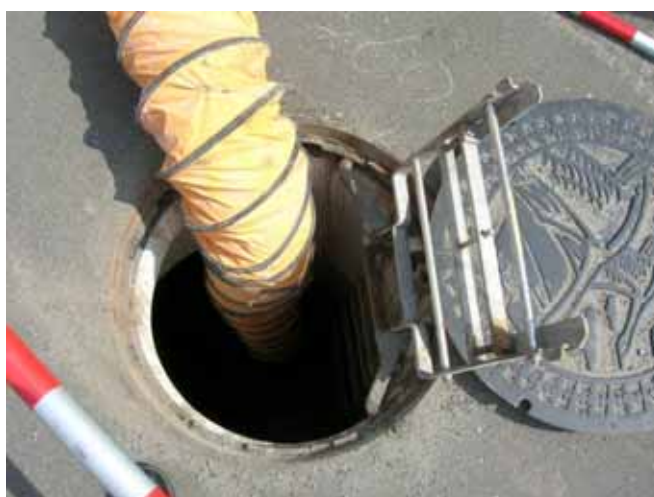
写真 6-10 No.95 マンホールの内部写真
