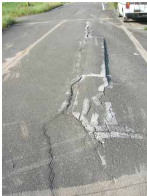
写真 6-36 No.1088-2～1088-1 路面状況
