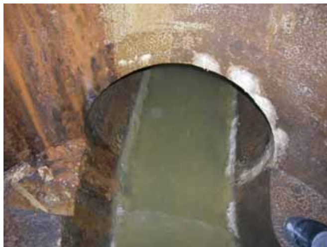
写真 6-33 No.185-1 マンホールの流下状況
