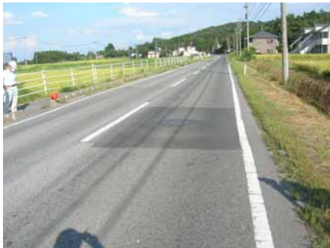
写真 6-35 No.185-1 路面状況
