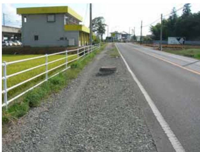
写真 6-7 測定箇所（未対策 No.714 マンホール）
