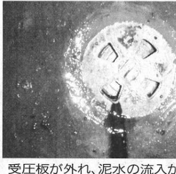
受圧板が外れ、泥水の流入が確認できる
