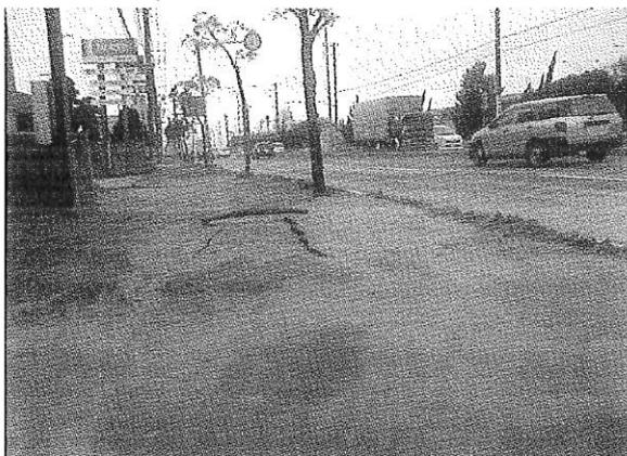
川浜、海浜幕張）を通ったが、そこでも道路上での亀裂および液状化現象が発生しており、電柱や電話ボックス、ブロック擁壁等の倒壊を目の当たりにした。また、10cm～20cmのマンホールの浮き上がりも発生していた（写真-1、2）。
